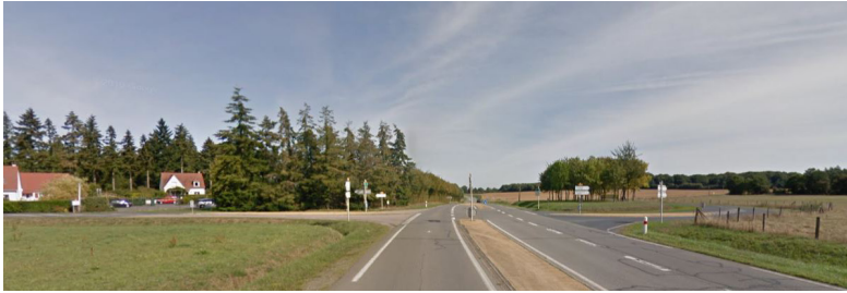
Carrefour RD562 et RD156 à Saint-Laurent-de-Condé
