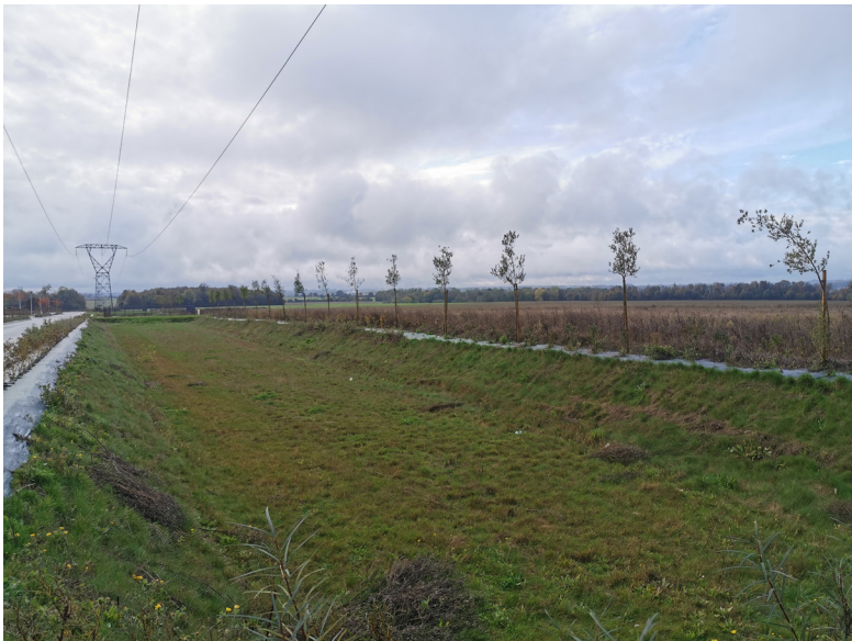
Ligne électrique à Bretteville-sur-Laize
