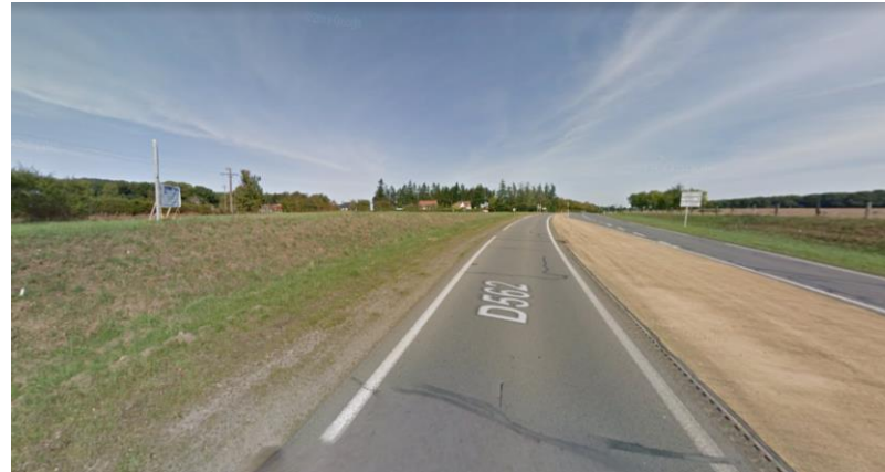
La RD 562 à Saint-Laurent-de-Condé Source : https://www.google.fr/maps/
